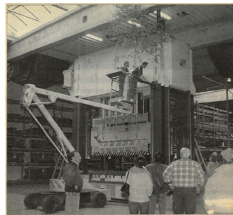
Größter Kran Deutschlands kam nicht ins Schwanken Aufsehen erregte am Samstagmittag der größte Kran Deutschlands im Gewerbegebiet Georg-Weierbach. Das 122-Tonnen schwere Gerät lieferte Einzelteile für die Montage einer neuen Presse ins Werk der Firma Loch. Durch das Hallendach manövrierte der Kran des Trierer Unternehmens Steil die Teile für die 800-Tonnen schwere Presse. Der Auslegerlänge von 108 Metern konnte auch das Unwetter am Samstag nichts anhaben – die riesigen Metallteile schwebten unbeschädigt in die Produktionshallen. Zwei Millionen Euro investiert der Automobilzulieferer damit nach eigenen Angaben in seine Konkurrenzfähigkeit. Foto: Greber
