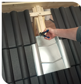
3 | Hintere Aufkantung an Markierung nach vorne umlegen.
